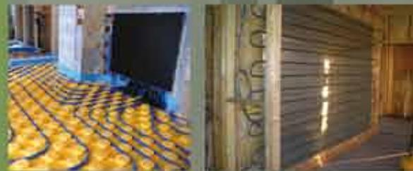
L'impianto a pannelli radianti è un sistema per riscaldamento e raffrescamento degli ambienti con possibilità di posa a parete, pavimento o soffitto. È costituito da serpentine in rame preassemblate per una facile installazione oppure da serpentine in plastica da assemblare in loco o già inglobate in pannelli di cartongesso.
