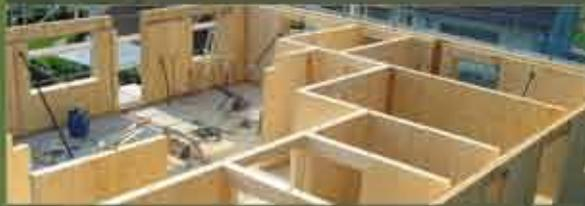
Realizziamo edifici sicuri e duraturi utilizzando elementi prefabbricati in legno, prodotti con tecnologia X-LAM, sistema costruttivo INNOVATIVO, SISMORESISTENTE, IGNIFUGO e TERMOISOLANTE.
