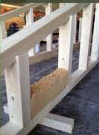
esternamente ed internamente con un pannello di irrigidimento OSB e isolate con fibra di legno naturale; i rivestimenti esterni possono essere personalizzati secondo le esigenze del cliente, sempre con cappotti in fibra di legno.
