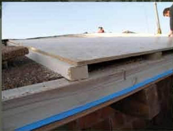
Una tipologia di tetto è quella costituita da un sistema ventilato in grado di fornire una protezione che permette al calore accumulato dal manto di copertura di sfogarsi verso l'alto, riducendo così la trasmissione verso l'interno e sostituendosi di fatto ad un isolamento vero e proprio.
